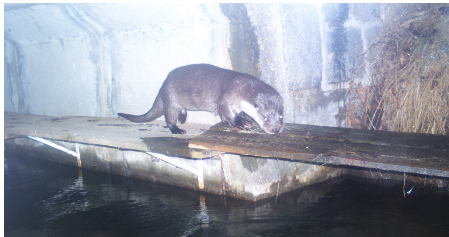
Dřevěné lávky podél stěny mostu umožní vydram projít podmostí, kde se dříve bály
